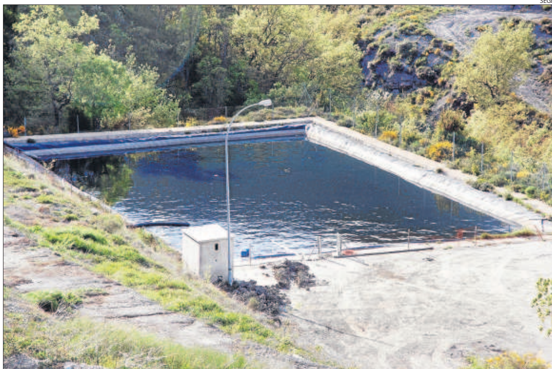
Imatge presa ahir de la bassa de lixiviatos on es va registrar el vessament.
