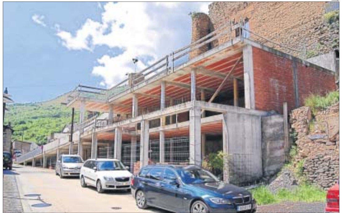
L'estructura de la futura biblioteca es va aixecar fa més de set anys.
