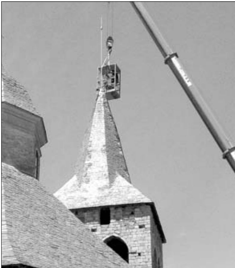
Momento de la instalación del pararrayos
