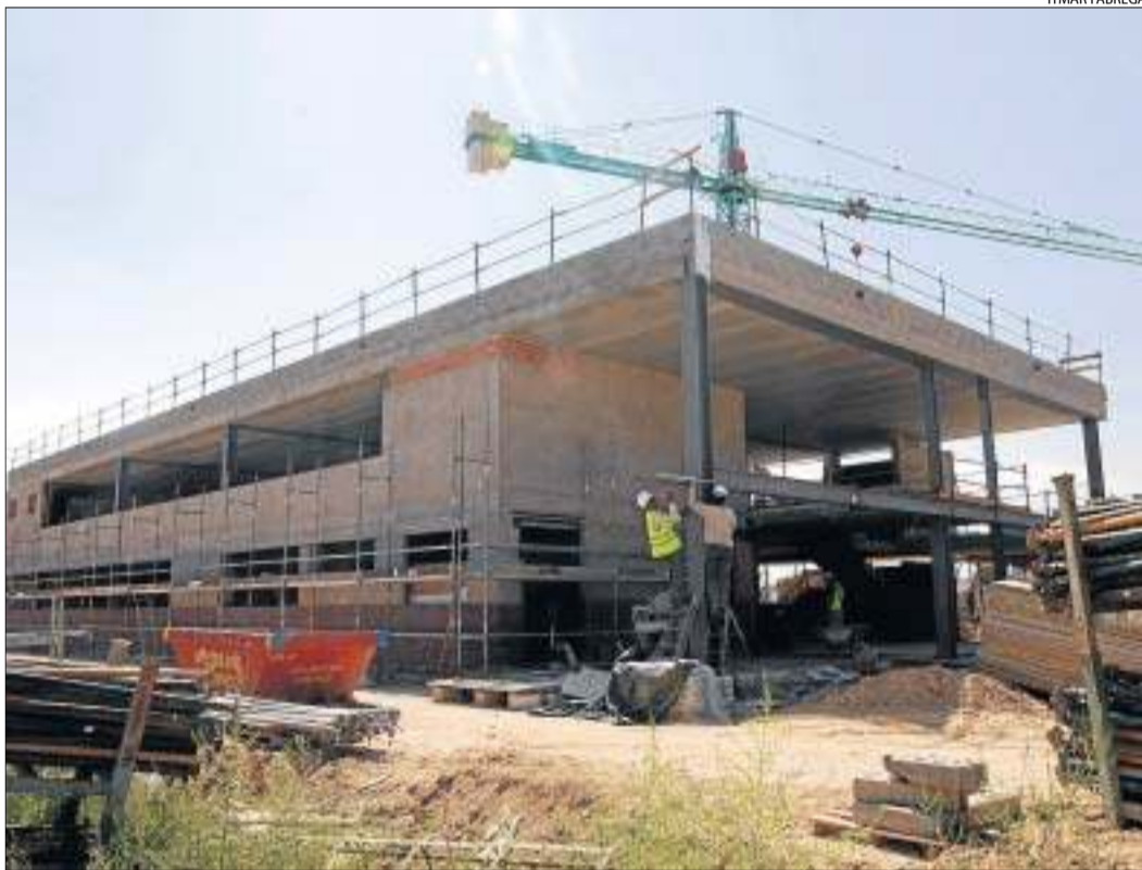
La construcció de l'edifici per a primària al col·legi Parc del Saladar d'Alcarràs.
