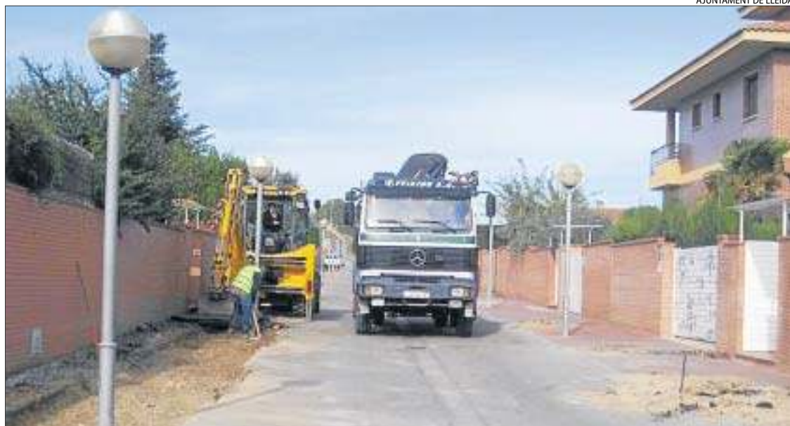
Els operaris encarregats de les obres han aixecat el paviment i han arrencat els arbres.
