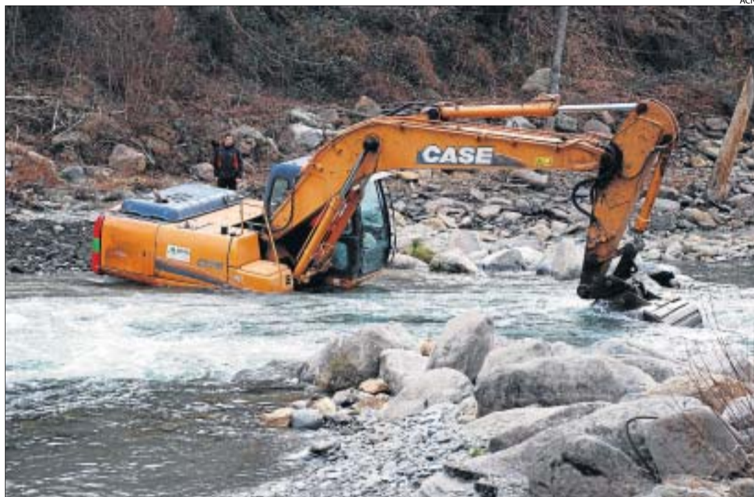
Una màquina excavadora resitua les pedres que van ser arrossegades per les riudes.
